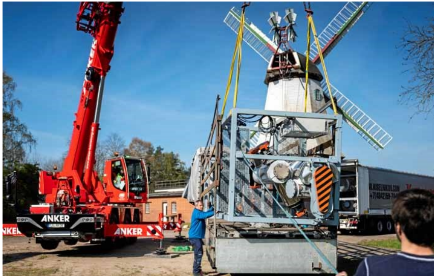
Die Pilotanlage wird in Einzelteile zerlegt und am Zwischenlager an der Windmühle in Artlenburg abgeladen.
